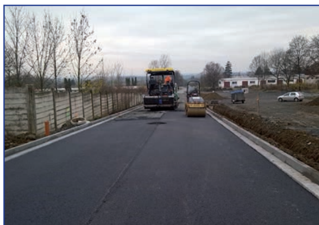
Ilustracja 23: Prace budowlane w strefie ekonomicznej Šternberk, wrzesień 2013. Źródło: archiwum miasta Šternberk.
