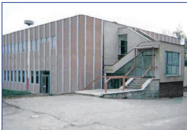
Ilustracja 32: Obiekt dawnej siedziby Spółdzielni Rolnej Bohuňovice, stan przed remontem. Źródło: archiwum gminy Bohuňovice.
