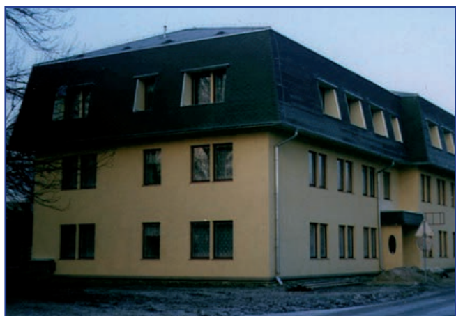
Ilustracja 33: Skrzydło mieszkalne Centrum Zdrowia po ociepleniu i zadaszeniu w latach 1997 i 1998. Źródło: archiwum gminy Bohuňovice.
