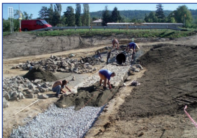
Ilustracja 22: Prace budowlane w strefie ekonomicznej Šternberk, wrzesień 2012. Źródło: archiwum miasta Šternberk.
